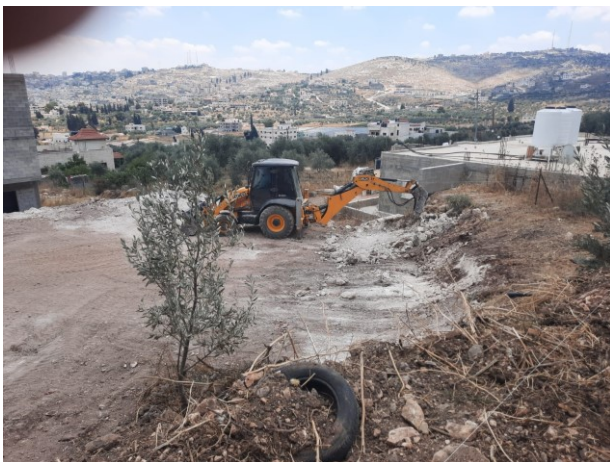
Le bulldozer est au travail pour aménager le terrain
